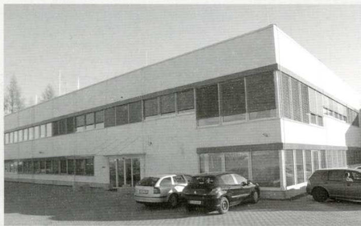
Nová budova Tiskárny Grafico v Opavě-Kylešovicích
